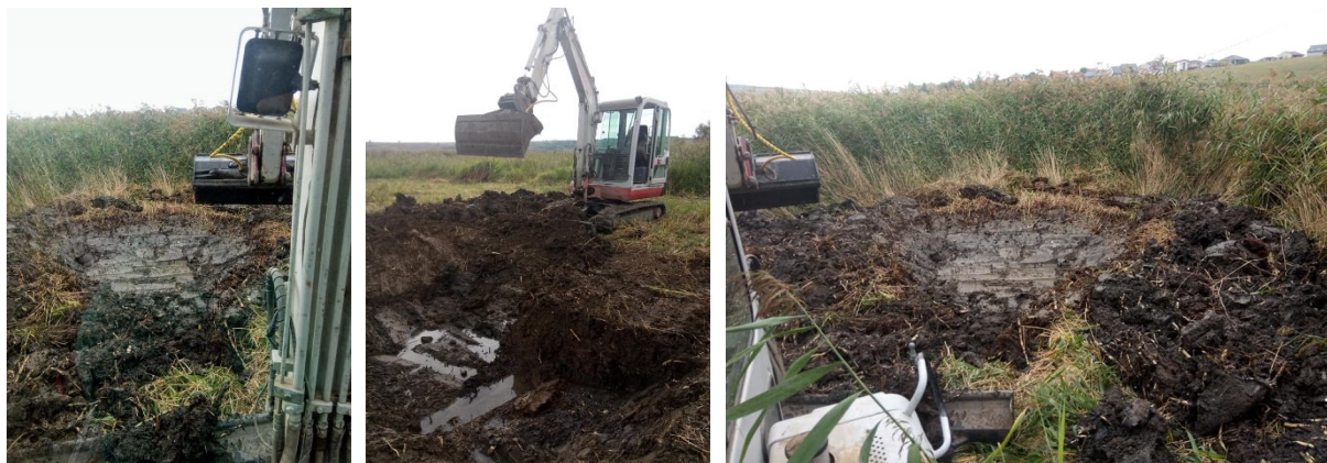
Obr. 3. Hloubení tůní s využitím lehké mechanizace dne 3.9.2020. Foto M. Valihrach.
